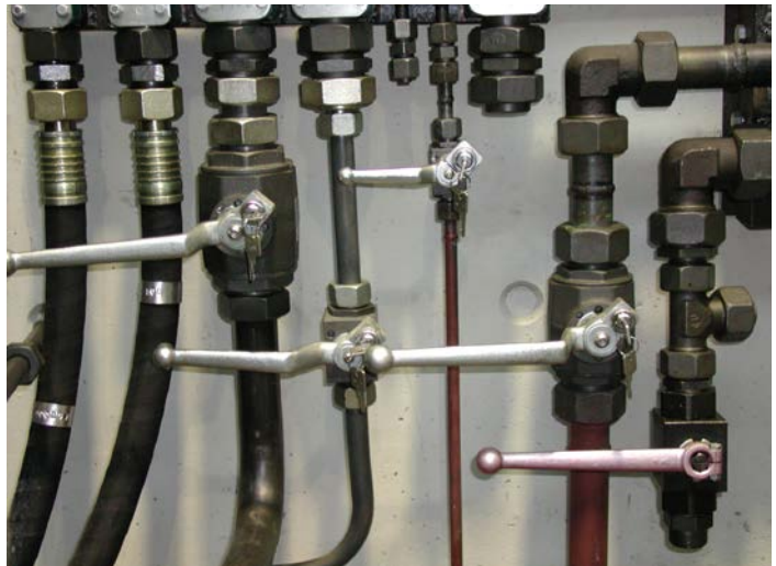
Abb. 3 Sichern gegen Wiedereinschalten durch abschließbare Kugelhähne
