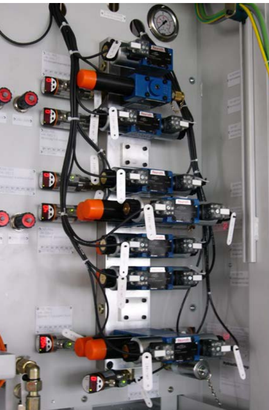
Abb. 20 Kennzeichnung von Hydraulikventilblöcken
